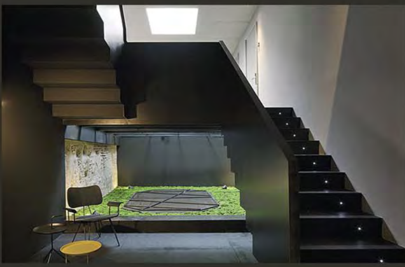
Un pavimento de vidrio transitable resuelve la última planta permitiendo el paso de luz desde la cubierta a la planta baja a través del lucernario de la segunda planta, situado inmediatamente encima de la escalinata.
